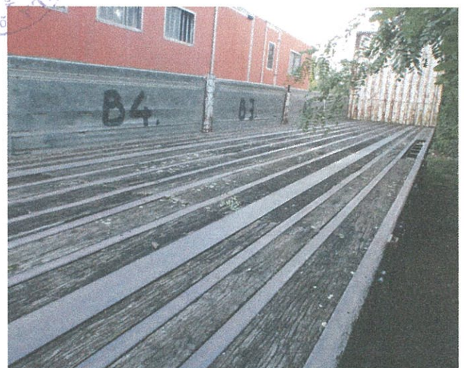
plató dezska repedezett, jobb elől hiányos
